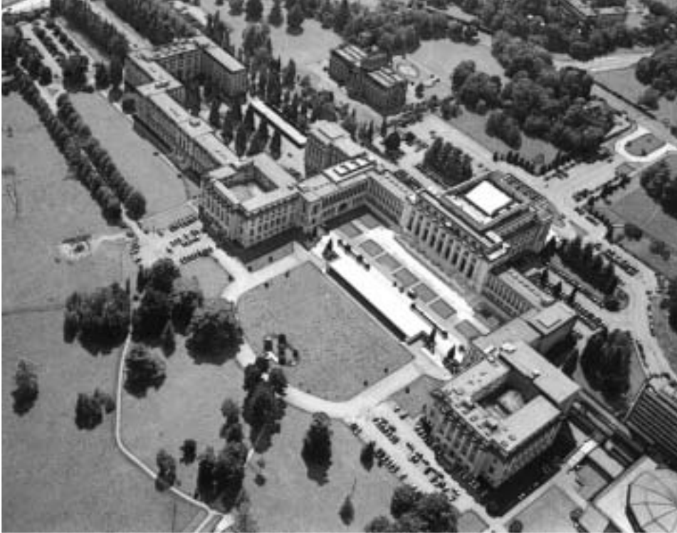
Abb.: Völkerbundspalast in Genf.
